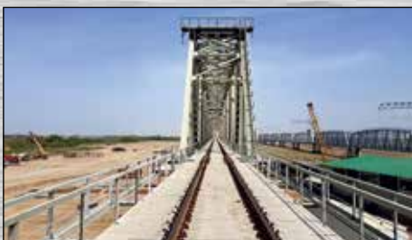
Железнодорожный мост Туркменабат-Фарап
